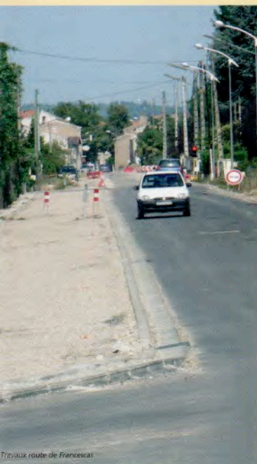
Travaux route de Francescas
