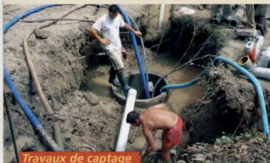
Travaux de captage
