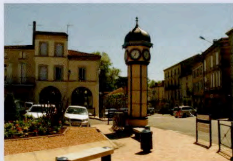
Exemple de travaux en régie : la peinture de l'horloge
